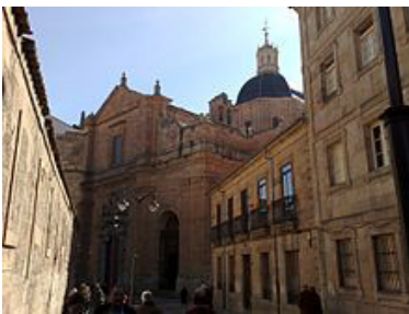
Convento de las Agustinas e Iglesia de la Purísima
